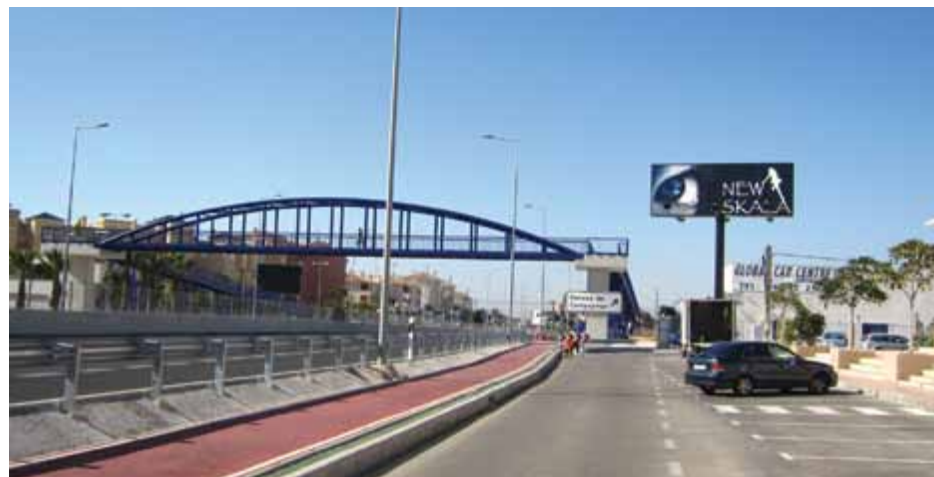
Gangbroen over den sterkt trafikkerte N-332 ved La Regia ved Campamor på Oihuela Costa er nå endelig på plass.
