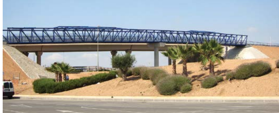
Endelig er gangbroen over motorveien til og fra "La Zenia Boulevard" på Orihuela Costa ferdig.
